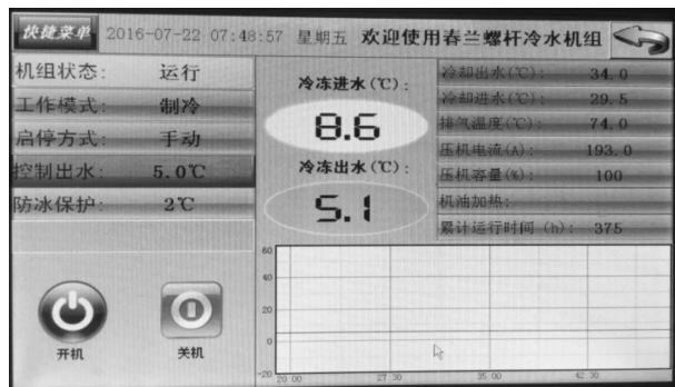
图 7 机组运行时操作主页界面显示
