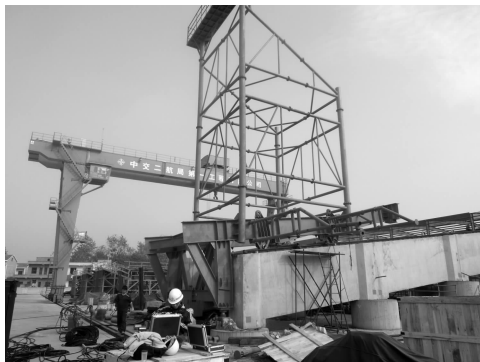
图 10 滑道井字梁调位施工现场照片
