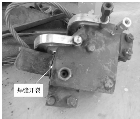
图 3 金属密封胶加固装置与管道焊缝振裂
