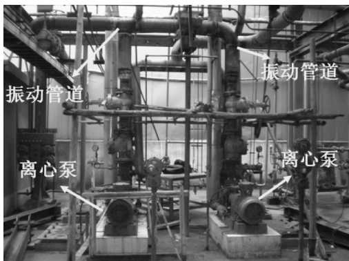
图1 离心泵进出口管道实际分布图
