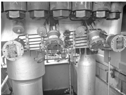
图5 温度补偿装置的电加热器安装
